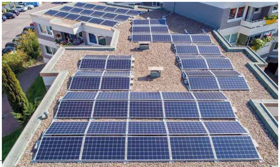
Installazione del fotovoltaico.
