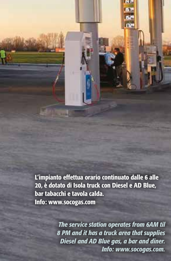
La colonnina che eroga LNG per mezzi pesanti.
